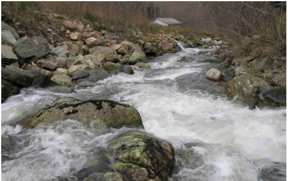
Figur 15. Dette biletet er tatt nedstrøms frå litt oppom kraftstasjonen. Stasjonsbygningen ser ein i øvste biletkant litt til høgre for midten i biletet. Akkurat her kan det sjå ut som om elvelauget delvis er reinska for alle lausmassar slik at fjellet stikk fram fleire stadar, men i følgje Olsen er dette digre kampesteinar. (Foto; Oddvar Olsen for Bioreg AS © 26.01.2017).
