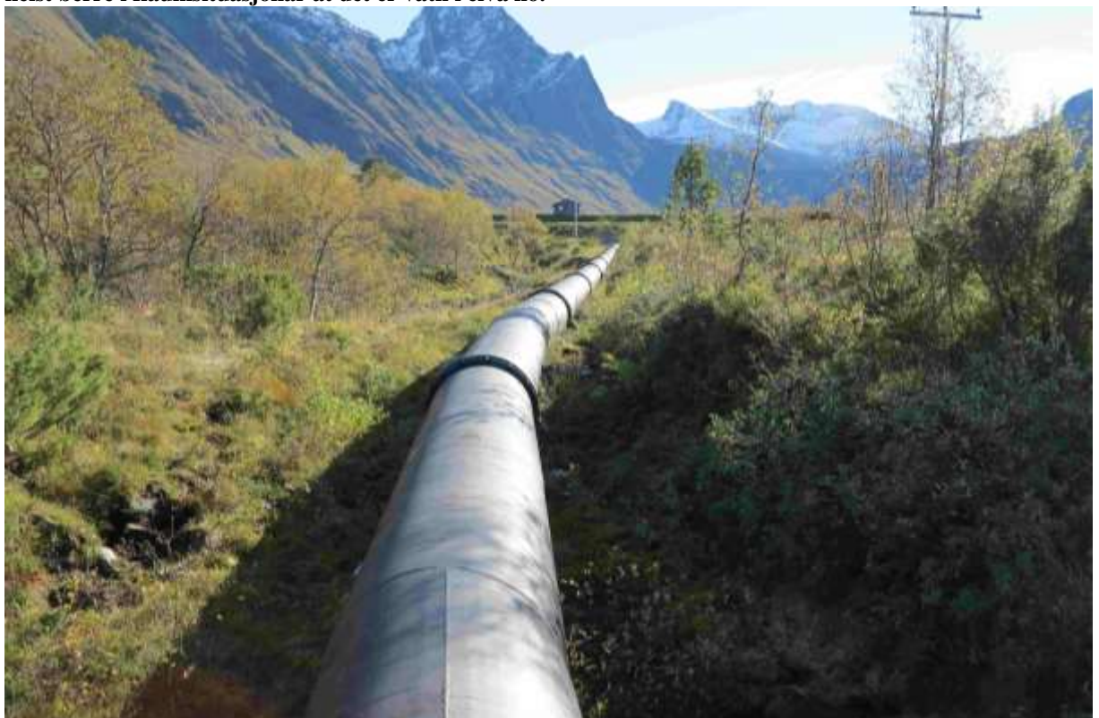
Figur 12. Foto; Oddvar Olsen for Bioreg AS © 05.10.2016. Biletet viser øvste delen av røyr gata slik ho er no. Som ein ser så er det to røyr lengder som har ein tydeleg knekk her. Det er meininga at det nye røyret skal få ei meir avrunda utforming, noko som medfører at den nye røyrtraseen kjem noko meir til høgre enn på dette biletet.
