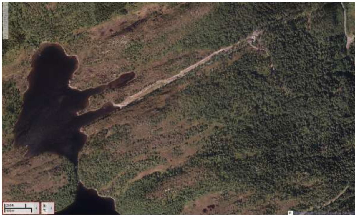
Figur 3. Dette flyfotoet ble tatt i 2012 og viser vegstrekningen fra inntaket og ned til kryssingen av elva. Dette er da tatt rett etter at vegen ble restaurert etter en større flom. Det betyr at det enda har gått forholdsvis kort tid siden de siste inngrepene ble gjort her og en må forvente en sakte revegetering selv om ikke spesielle tiltak blir satt inn.
