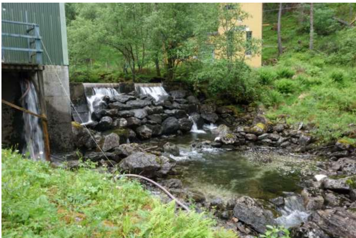
Figur 28. Her ser ein dammen i Risaskarelva som er rekna som absolutt vandringshinder. Dette ligg om lag 900 meter ovafor der Risaskarelva renn ut i Storelva, og denne er bygd i samband med inntaket til Vartdal vassverk. Også eit settefiskanlegg har vassinntaket sitt i denne dammen. (Foto; Solfrid Helene Lien Langmo © 21.06.2013).
