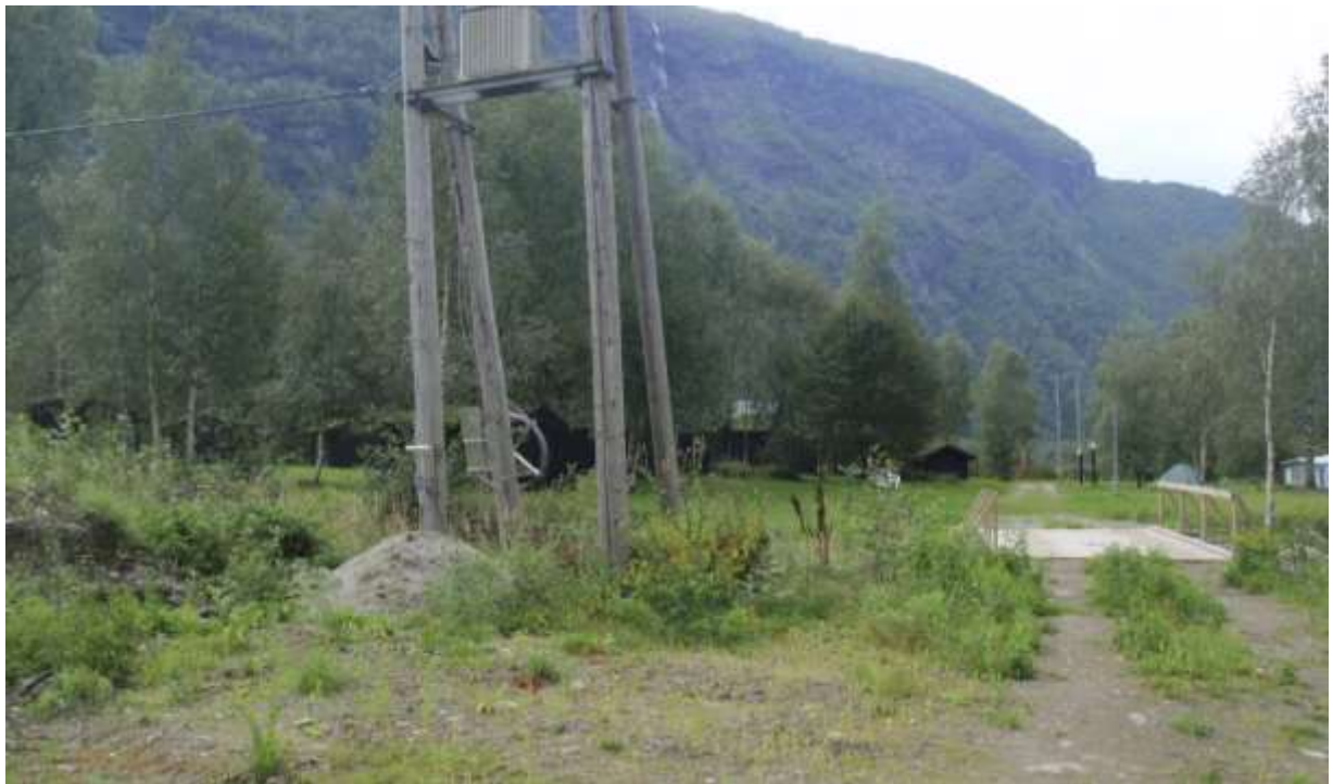
Figur 12. Biletet er teke like nedanfor rv. 55 ved Åselvi. Den produserte straumen vil verta overført til høgspantlina vi ser på biletet. Elles så ser ein at området langs elva er forstyrra, med campingplass på eine sida, og diverse vegar og anna anleggsarbeid på andre sida. (Foto: Bioreg AS ©).
