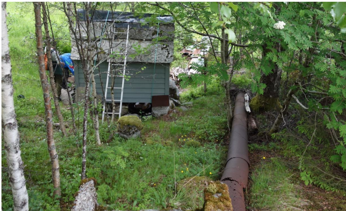
Figur 12 Her ser ein det nyrestaurerte kvernhuset til venstre i biletet. Til høgre i biletet ser ein jarnrøyra som gjekk til sagbruket. Dette kan ein så vidt skimte restane av nedanfor kvernhuset. Fotografen står i enden av betongrenna som er støypt frå elva, og som sytte for vasstiltførselen. I biletet ser ein av kartleggjarane, Oddvar Olsen saman med grunneigar Karl Martin Gudmundsos som viser fram kvernhuset. (Foto; Solfrid Helene Lien Langmo © 19.06.2013).
