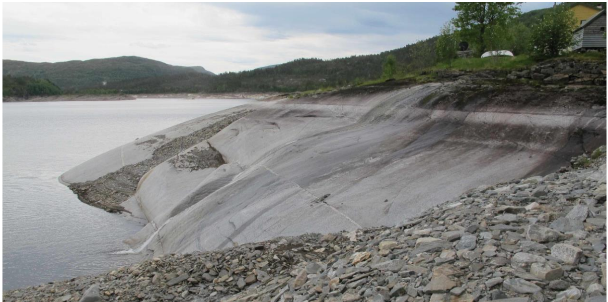
Figur 8. Biletet viser utløpet av Oselva i Nordstrandsvatnet. Som ein ser stengjer eit bratt svaberg for all oppgang av fisk så sant vatnet ikkje er heilt fullt. I fylgje grunneigaren gjekk vatnet i magasinet heilt opp til steinane ved utløpet av elva når det er fullt, eller slik det var før nedtapping. Ut frå dette, samt at gytesubstrat var mest totalt fråverande i dei nedre delane av Oselva, må ein konkludera med at elva neppe spelar særleg rolle som gyteelv for fisken i Nordstrandsvatnet slik situasjonen er no (Foto; Oddvar Olsen © 19.06.2013).
