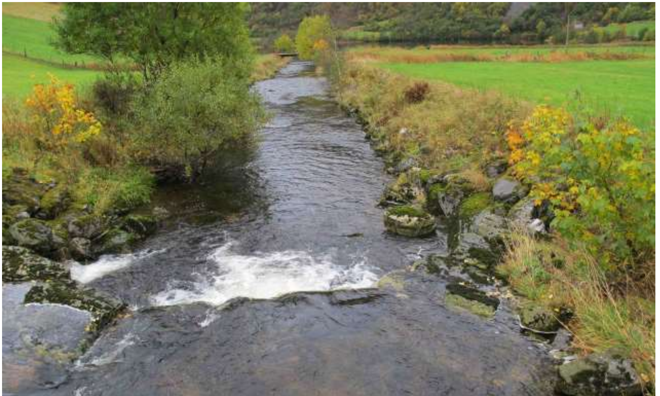
Figur 13. Biletet viser elvestrekning i den nedste delen av Støselva. Her ser ein tydeleg det som Hellen mfl. (2000) nemnde, at kantane er plastra, og at det er steinsette tersklar i elvebotnen (Foto; Oddvar Olsen © 06.10.2012).
