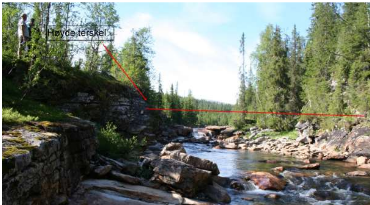
Figur 6. Her ser en samme stedet med terskelen antydnet, men nå sett oppstrøms. (Foto og montering; Henning Tjørhom, Småkraftkonsult AS).
