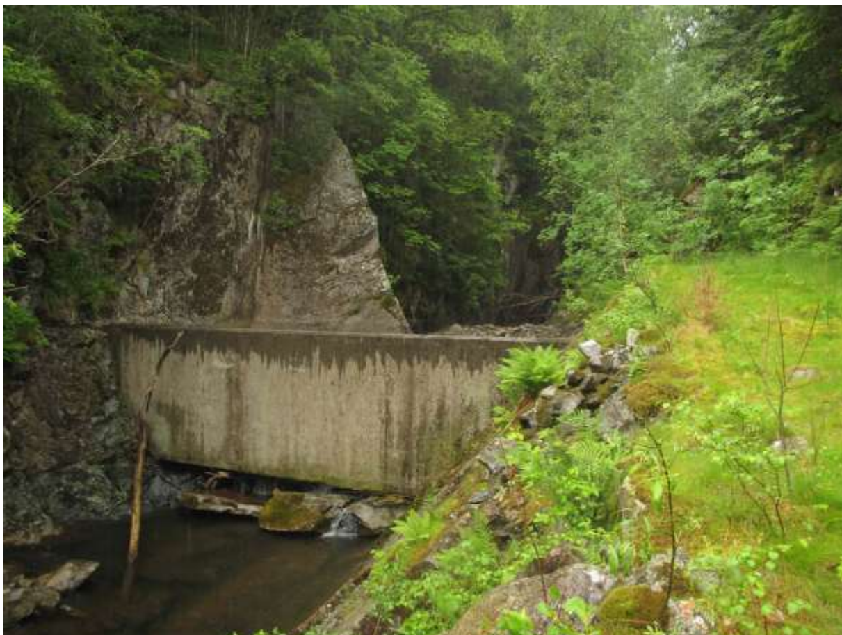
Figur 6. Foto; Torbjørn Høitomt, Biofokus © 29.06.2012. Dette bildet viser den omtalte betongdammen som skal forhindre at all steinføringen i elva blir ført nedover mot bebyggelse og dyrkamark ved eventuelle flommer. Gjennom tidene har det vært ganske mange skadeflommer i Valdraelva.
