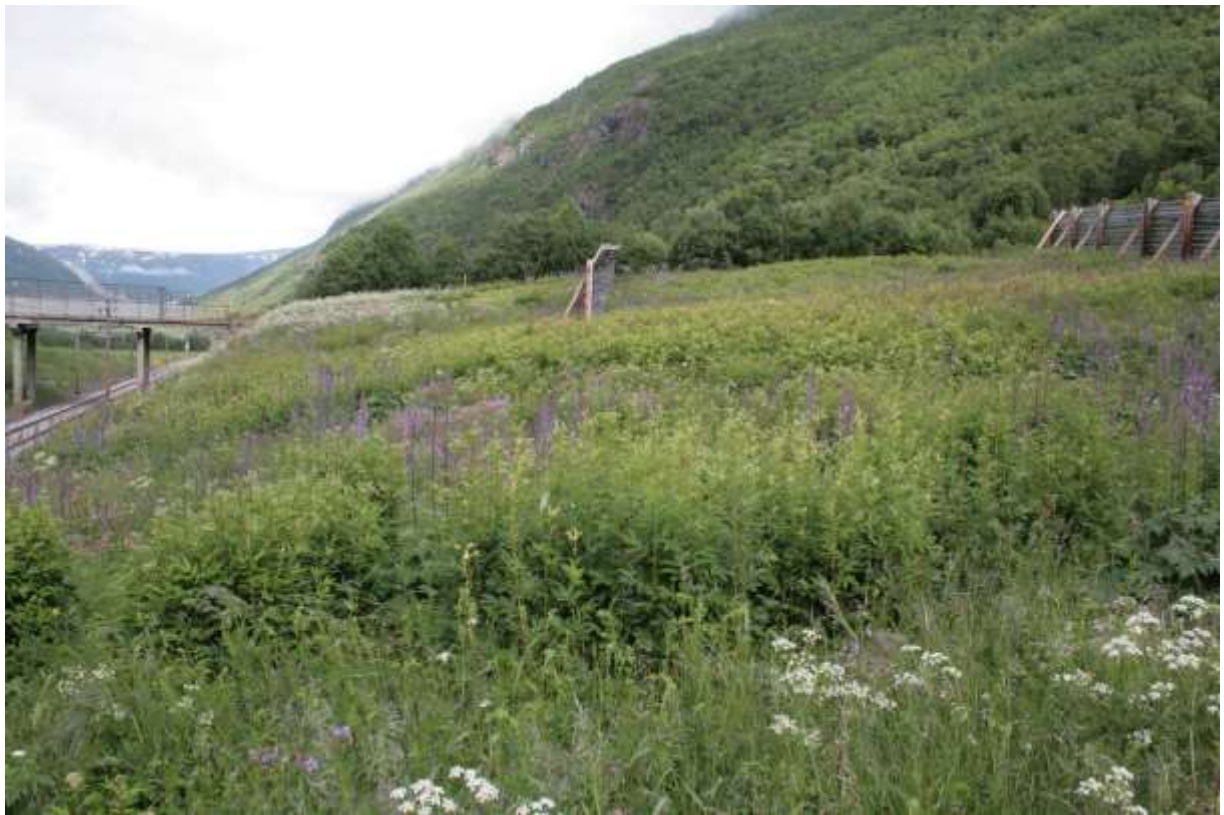
Figur 8. Lokalteten sett fra sør. På arealet står det snøskjermer. Det er også minst ei åpen grøft tvers over arealet. Skråninga ned mot jernbanelinja er noe magrere. Foto; Øystein Folden, 16.07.2012.
