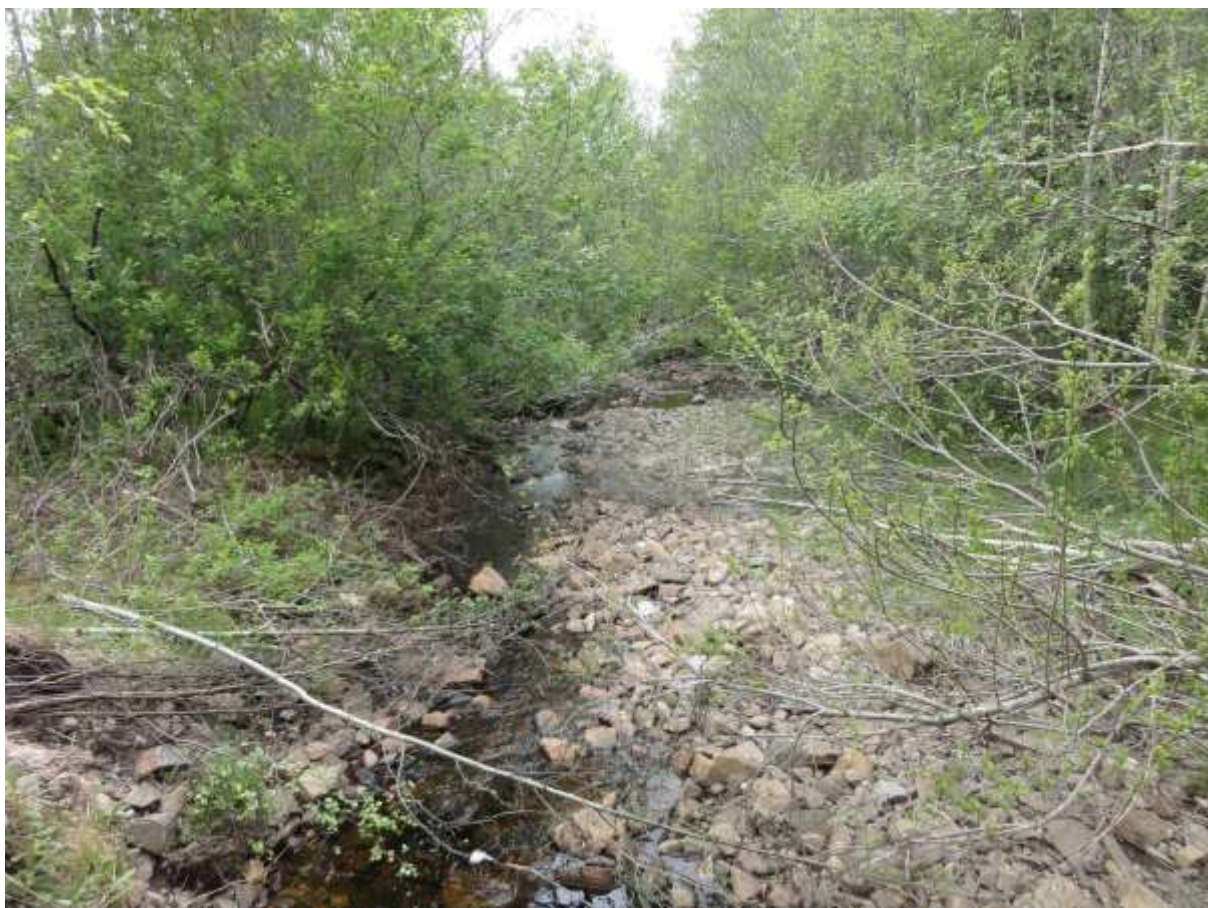
Figur 18. Bildet er tatt i retning E39 fra brua som krysser elva ved lunningsplassen. Som en ser er det ryddet litt kratt her, trolig for å gjøre det kjørbart for traktor fordi en ikke stoler på trebrua lenger. (Foto; Finn Gunnar Oldervik, Bioreg AS © 30.05.2012).
