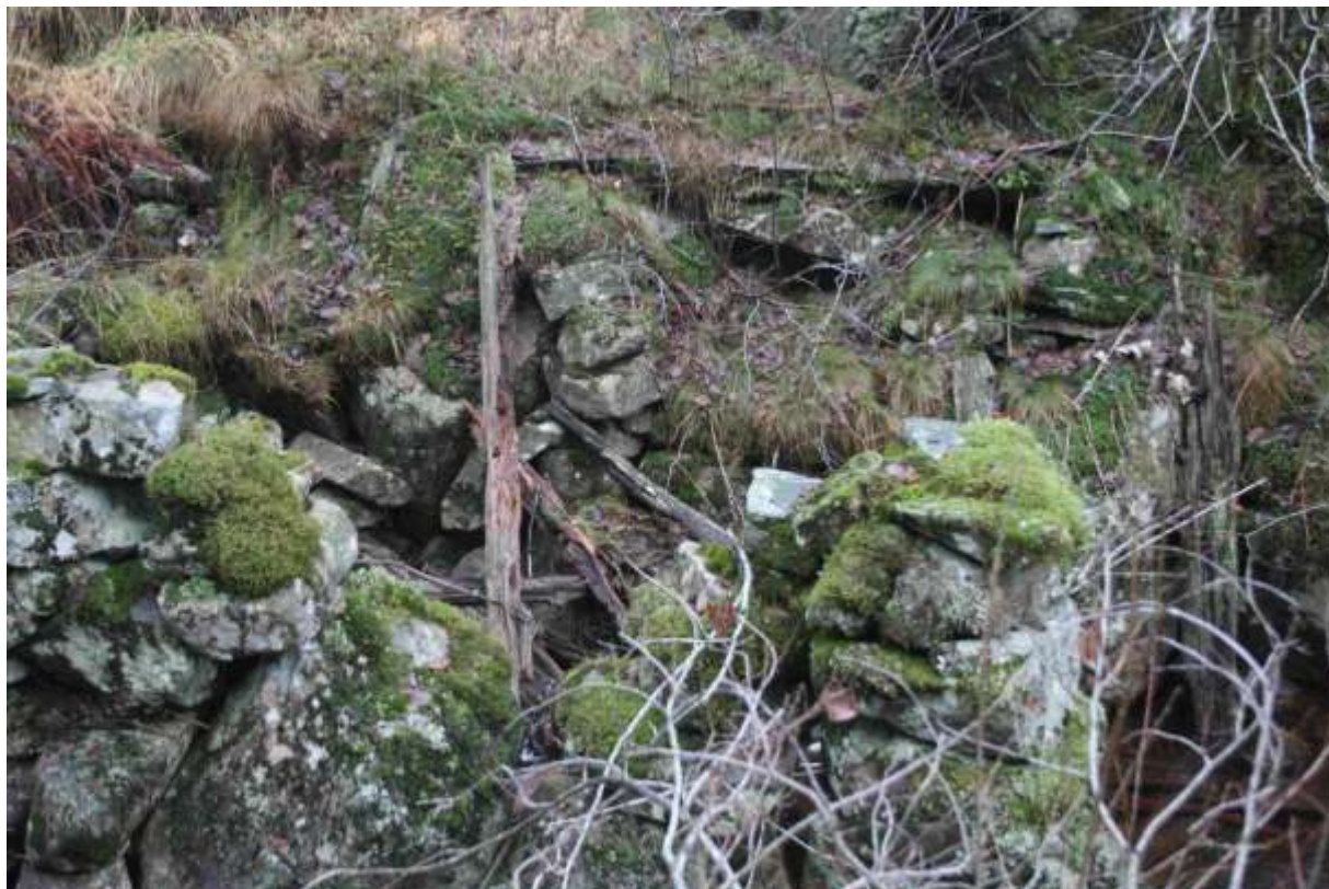
Figur 11. Litt nedenfor det planlagte inntaket kom vi over disse ruinene. Så langt har det ikke lyktes å få sikker kunnskap om hvilken bygning det har vært, men kanskje et kvernhus? (Foto: Karl Johan Grimstad © 21.11.2011).
