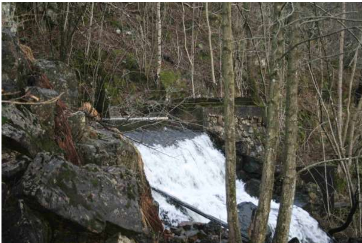
Figur 13. Noen hundre meter oppstrøms den planlagte kraftstasjonen ble det i 1950-årene etablert et vanninntak beregnet for drift av et kommunalt vassverk. Vassverket er ikke i bruk lenger, men kommunen sitter fremdeles med de fallrettene de tilegnet seg i forbindelse med etableringen. (Kilde; Per Hompland). Ved siden av inntaket er det en liten foss. (Foto; Karl Johan Grimstad © 21.11.2011).
