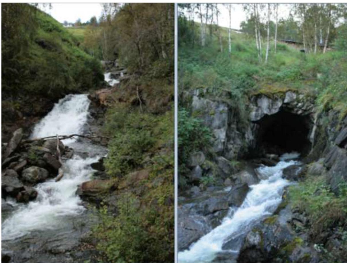
Figur 12. Bildet til venstre viser Rådåe oppstrøms jernbanen. Trolig har det havnet en del stein etter åkerrydding i elva i dette området, men storflommen i 2006 har nok også satt sine spor. Til høyre ser vi at elva kommer ut av tunnelen nedenfor jernbanen. (Foto; Bioreg AS ©).
