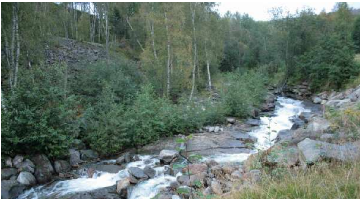
Figur 7. Her ser en Rådåe rett etter krysningen av jernbanen. Det er sprengt ut tunnel under jernbanen for elva og uren vi ser oppe til venstre på bildet er trolig tippområde fra tunnelbyggingen. Langs elva ser en at det vokser noe gråorkratt i tillegg til litt ung bjørk, noe som tyder på at det har vært hogd langs elva for ikke så veldig lenge siden. (Foto; Bioreg AS ©).
