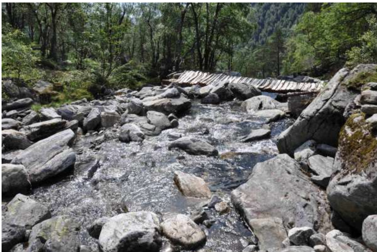
Figur 8. Litt over halveges oppe i lia kryssar ein sti Tverråni. Her har det då vorte bygd ei gangbru over elva slik at husdyr og menneskje kan kryssa elva på ein trygg måte. Brua var opphavleg plassert omlag der fotografen står, men flaum har ført brua ned dit ho no ligg. (Foto; Oddvar Olsen 15.07.2011 ©).
