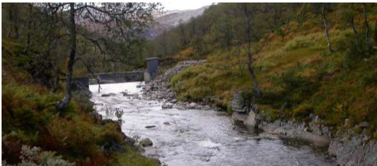
Figur 12. Biletet viser området og vegetasjonen ved området, for plassering av kraftstasjonen. I bakgrunnen ser ein inntaksdammen for det alt eksisterande Kaldestad Vassverk. (Foto; Finn Gunnar Oldervik ©).
