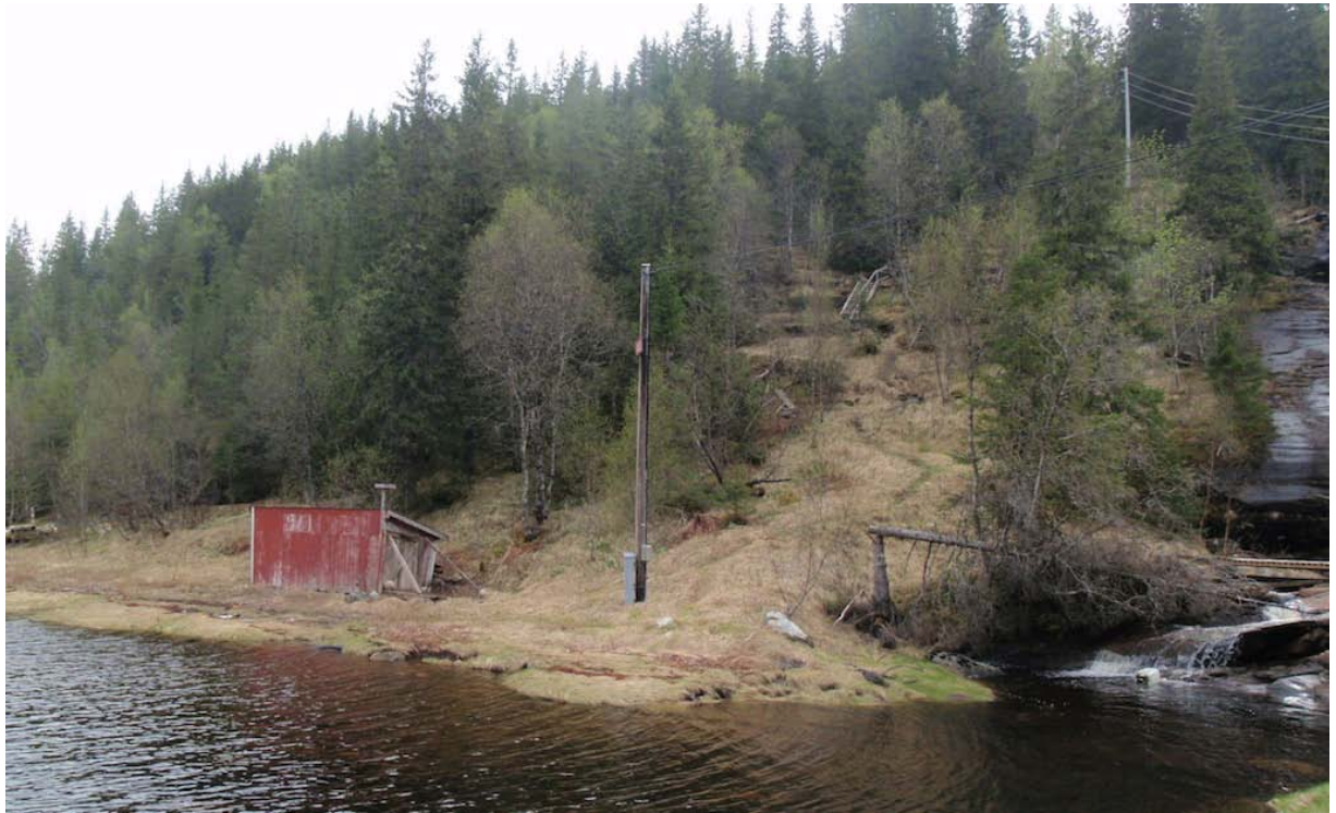
Figur 10. Bildet viser stasjonsområdet. Som en ser, så er vegetasjonen her forstyrret av diverse menneskelige aktiviteter. Trafoen for nettilknytning ligger like utenfor høyre billedkant. (Foto; Bioreg AS ©).
