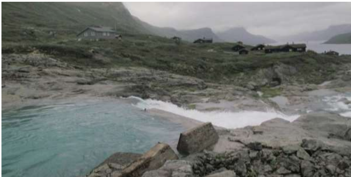
Figur 10. Biletet viser inntaksdammen til eit lite kraftverk som var i drift om lag frå midten av 1930-talet og om lag fram til 1960. Det var Eidsbugarden Høgfjellshotell som bygde dette og det vart nedlagd då dei vart knytt til det offentlege straumnett. (Foto; Bioreg AS ©).
