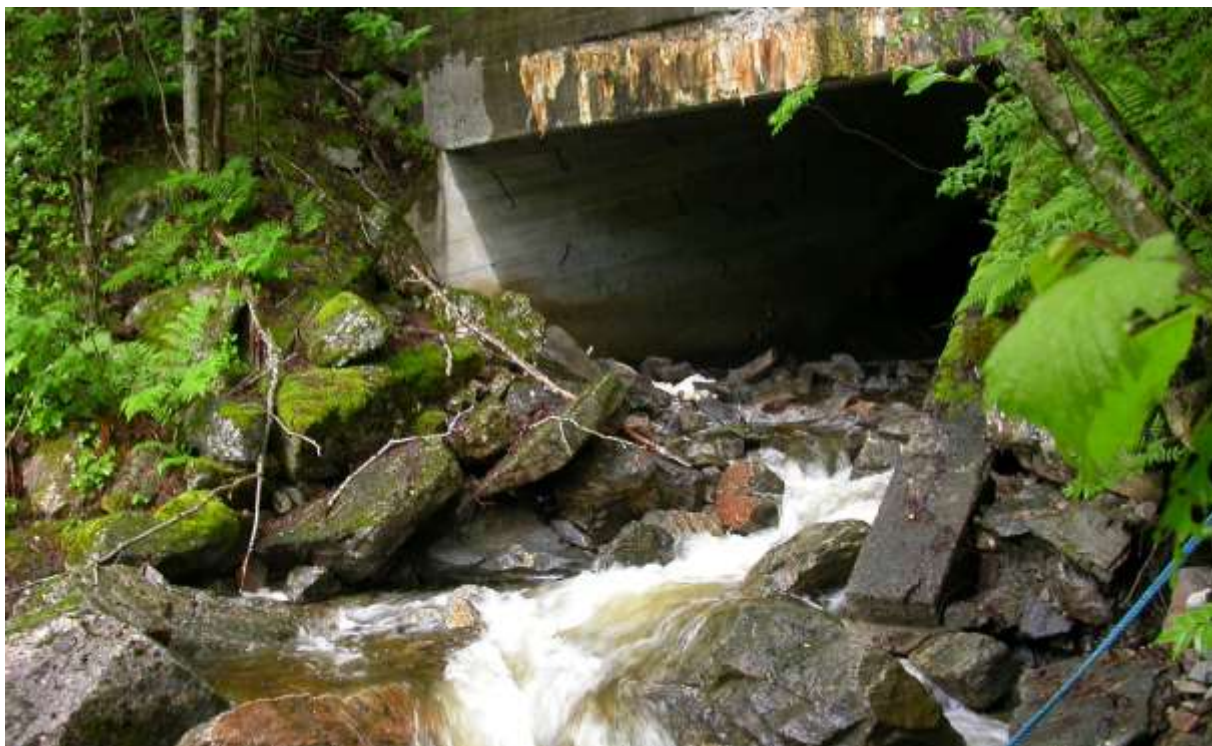
Figur 6. Det er rett nedenfor rv 65 at et nytt inntak skal etableres for et kraftverk nr. 2 i elva. På grunn av vegbyggingen er dette området ganske mye forstyrret av ymse menneskelige inngrep. (Foto; Bioreg AS ©)
