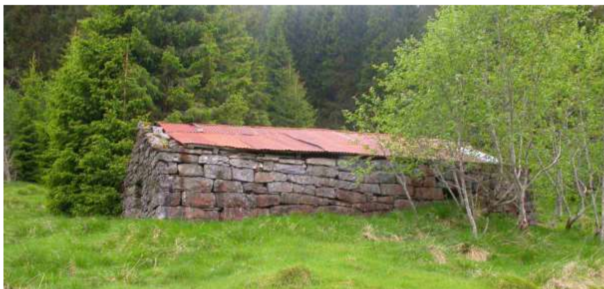
Figur 3. Det finst fleire slike mura fjøsbygningar i Stårheimsdalen, og når byggverket er utført som gråsteinsmur, så er det nok helst fordi høveleg trevyrke var mangelvare i bygda tidlegare. Om vi ikkje har misforstått, så vart desse fjøsa nytta som eit slags sommarfjøs eller vårstøl. Alderen på fjøset er det knapt nokon som veit lenger, men det kan kanskje vera på sin plass å minna om at på ein annan stad i Sogn og Fjordane med historisk sus over seg, nemleg på Losna er det også gamle fjøsbygningar av stein i overgangen mellom innmark og utmark. (Foto; Finn Gunnar Oldervik ©).
