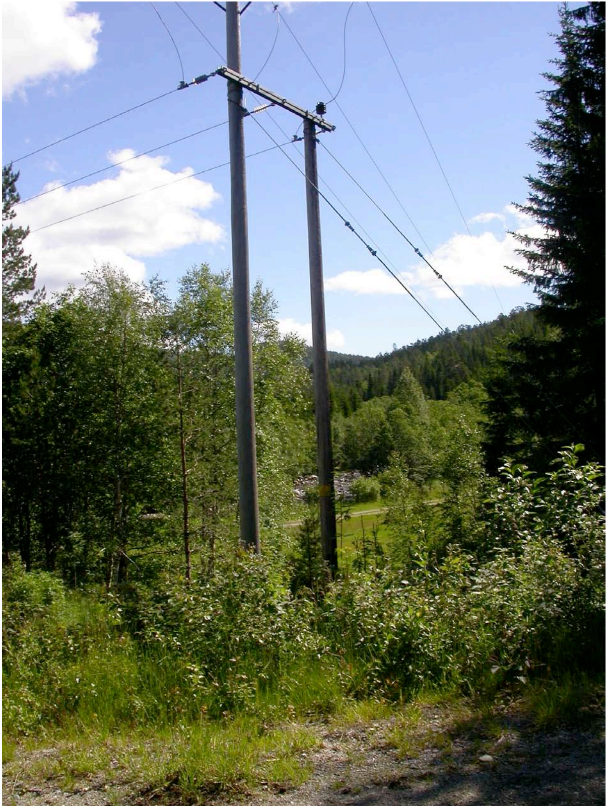
Figur 7. Rett i nærleiken av der kraftstasjonen er tenkt plassert går det ei 22 kV-line forbi. Det er planen å leggja jordkabel frå kraftstasjonen og fram til denne. (Foto; Finn Gunnar Oldervik ©).
