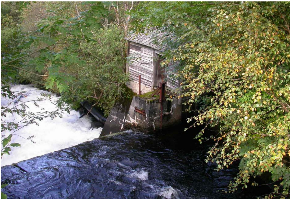
Figur 4. Biletet viser inntaket til det gamle kraftverket rett nedstraums utlaupet frå Herandsvatnet. Det er tanken å restaurera dette slik at det kan nyttast også til eit eventuelt nytt kraftverk i elva. (Foto; Finn Oldervik ©)
