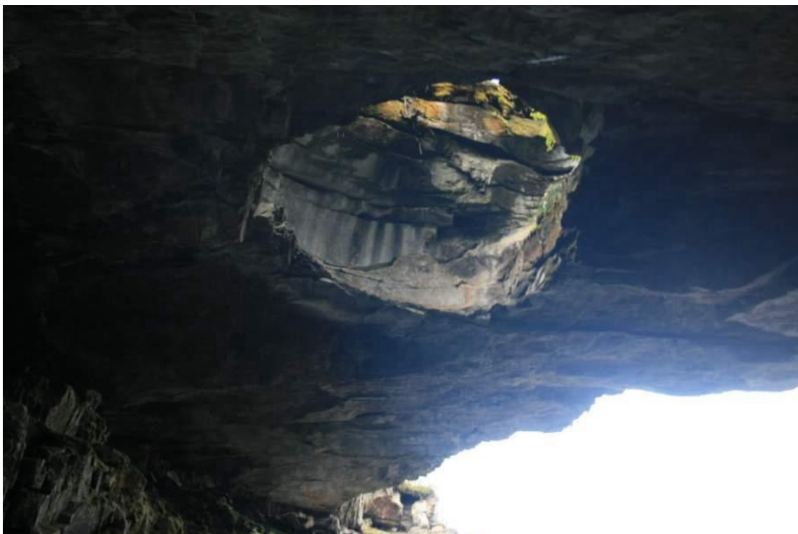
Figur 4. Dette bildet er tatt inne under Jordbrua og viser et hull i "taket" der inne. Hullet kan en se tett ved vegen som passerer over "brua". (Foto: Karl Johan Grimstad ©)
