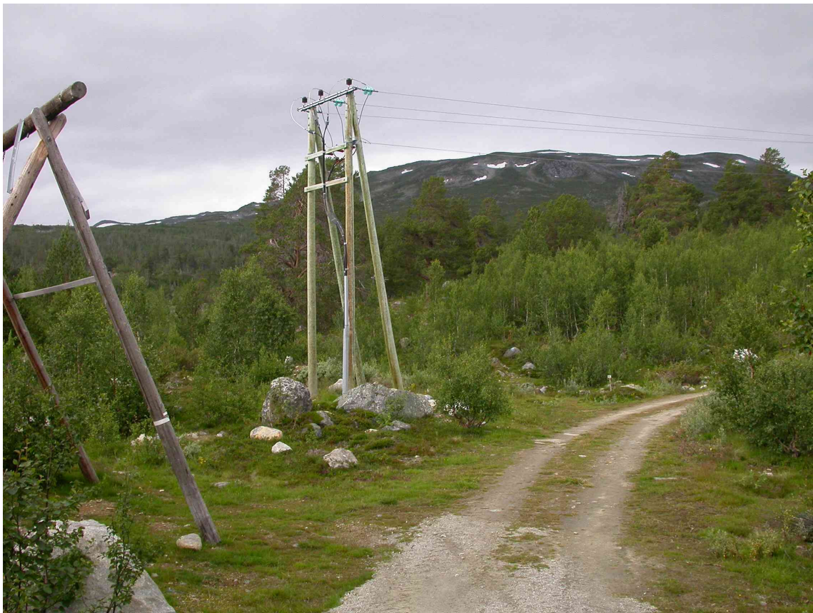
Figur 10. Det er ikkje særleg langt frå den planlagde kraftstasjonen og opp til denne høgspenmast, slik at ei kabelgrøft stort sett vil gå gjennom tidlegare forstyrta område. (Foto: Finn Oldervik ©).
