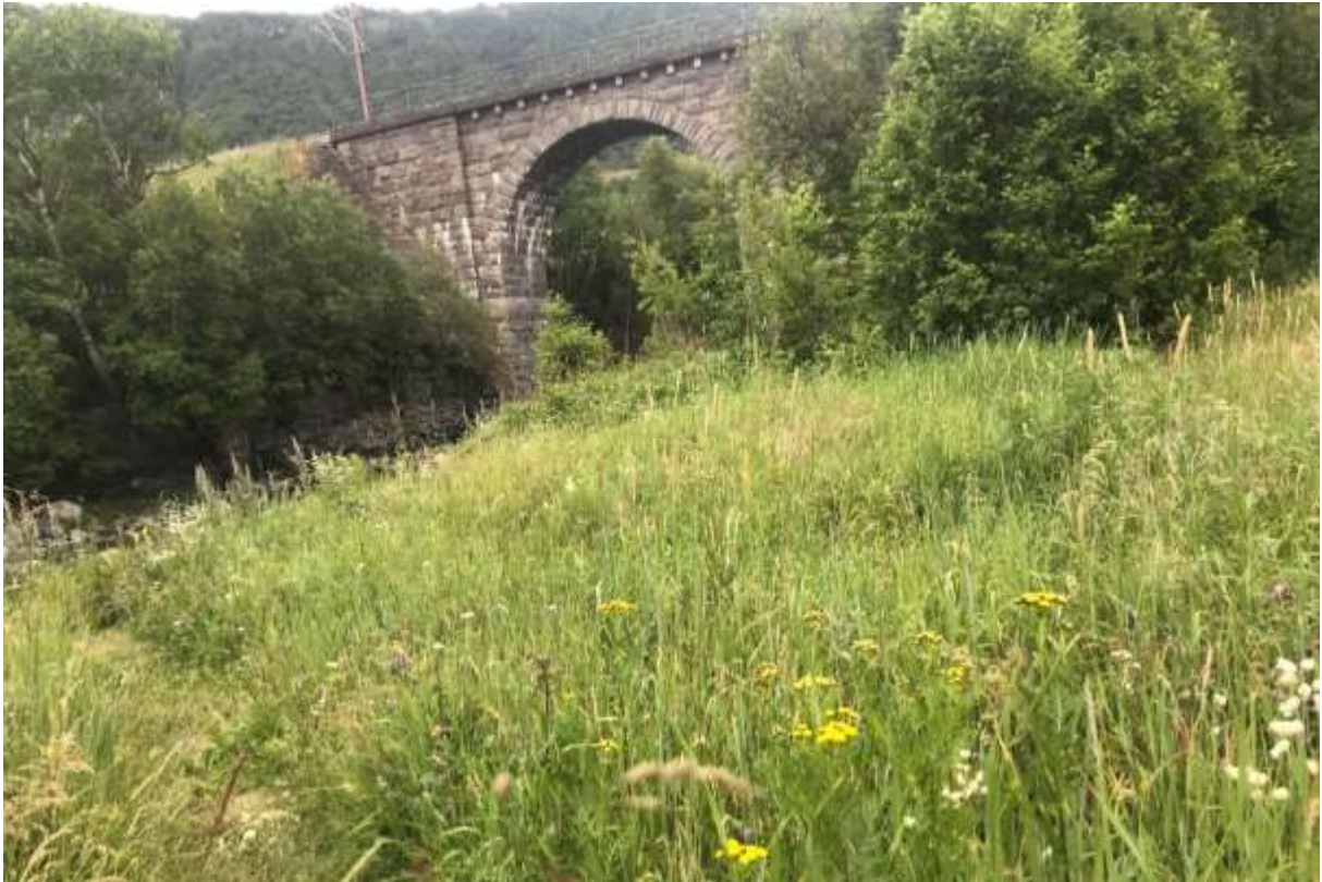
Figur 6. 32 V 532360 6933495 Bildet er tatt mot nord-øst og viser enga slik den ser ut ned mot elva. Noen av trærne opp mot brua kan med fordel hugges og kantsonen kan godt slås to ganger. Foto: Åshild Hasvik, Bioreg AS © 05.07.2018.
