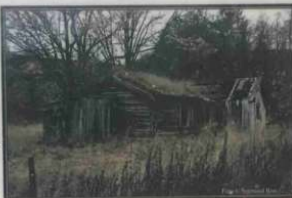
Plassstoggo før den ble restaurert
