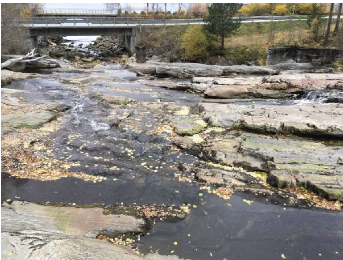
Figur 4. Bildet er fra nedre deler av Fessdalselva, og viser tydelig at berget her ligger lagdelt med mange sprekker. Foto; Solfrid Helene Lien Langmo Bioreg AS © 26.10.2016.
