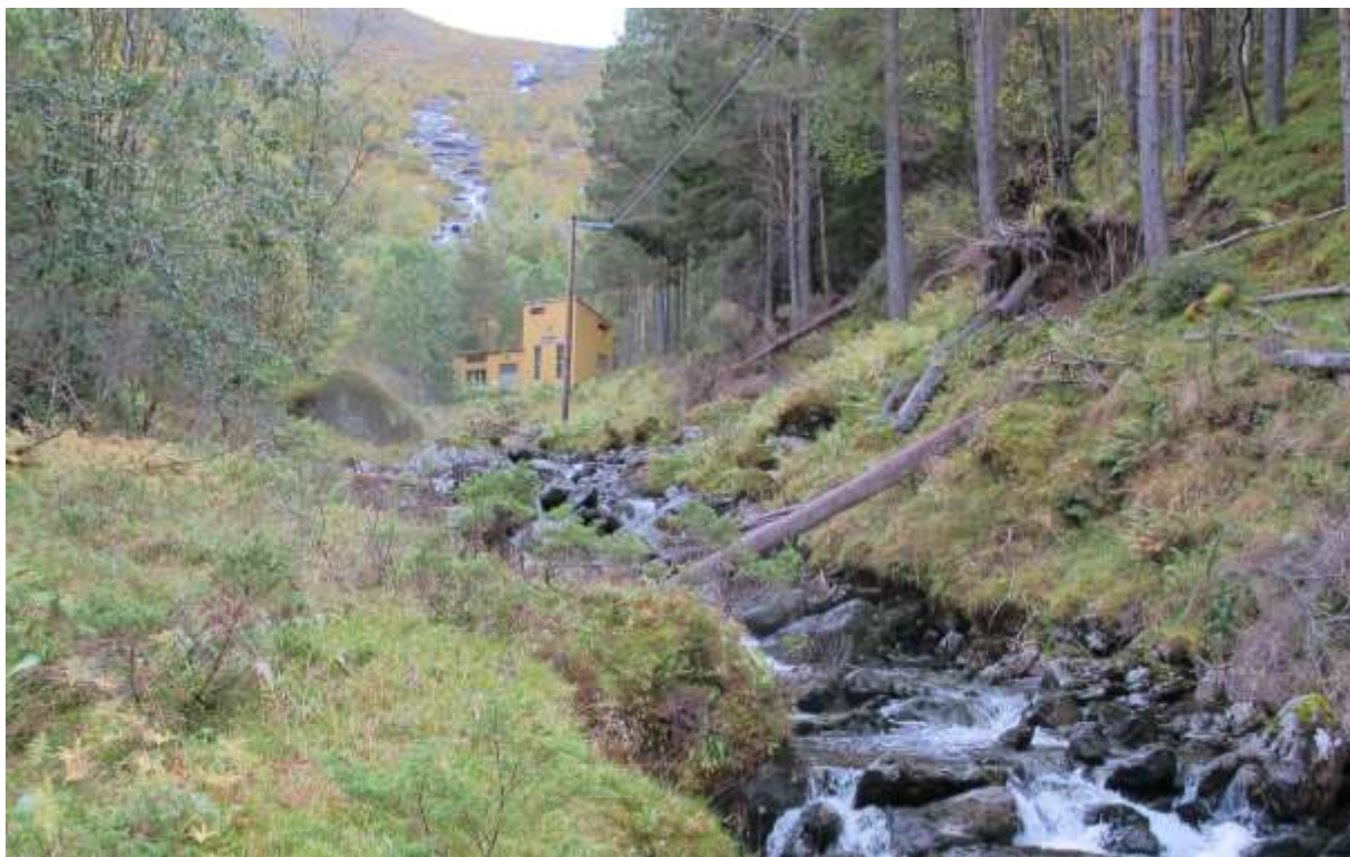
Figur 14 Biletet viser den allereie eksisterande kraftstasjonen i Risaskarelva og høgspantlina som går opp til denne. Ein ser også tydelig at elva er svært bratt og renn over nakne berg og sva ovanfor kraftstasjonen. Som ein ser består botnsubstratet i elva av mykje stor stein og blokk (Foto; Oddvar Olsen 28.09.2012 ©).
