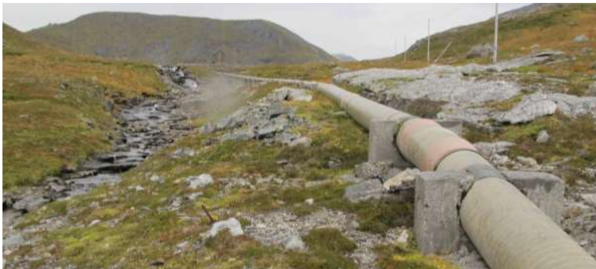
Figur 4. Her er vi litt nedanfor demninga i Litlevatnet i nærleiken av inntaket og ser oppover elva. Biletet viser i tillegg til elva, den eksisterande rørgatetråse i området. Vegetasjonen er prega av lågt rabbesamfunn og myrområde med innslag av artar som røsslyng, fjellmarikåpe, rome og blokkbær. (Foto; Oddvar Olsen, 28.09.2012 ©).
