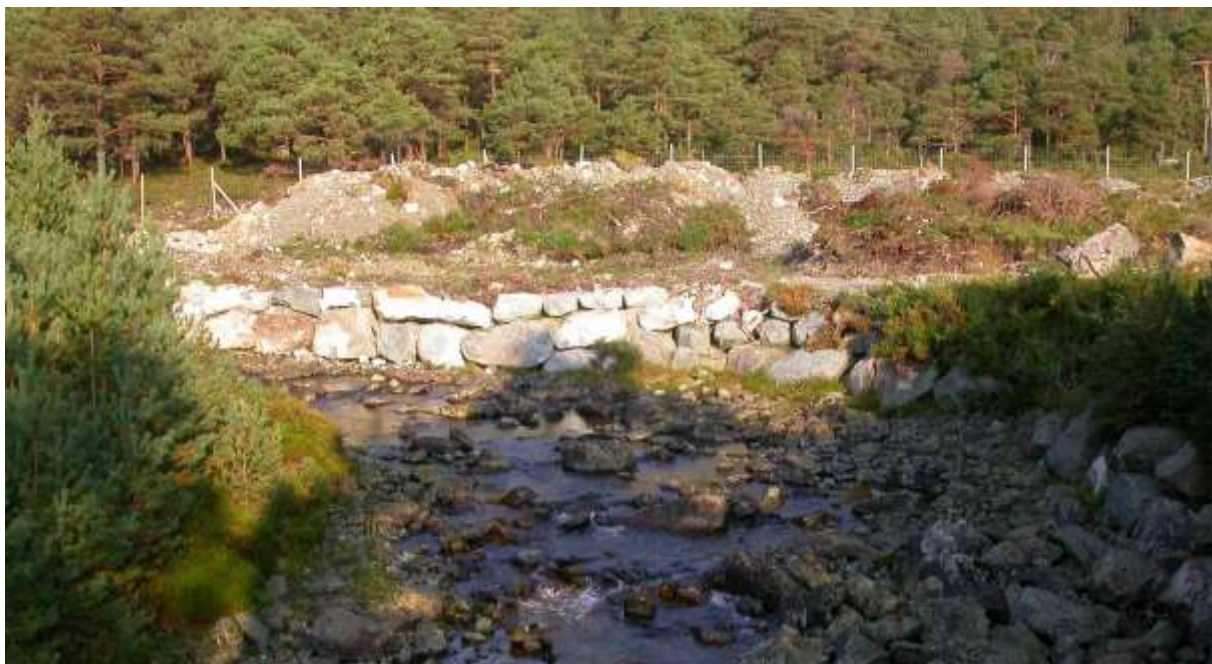
Figur 5. Det er ein stad i dette området ein har tenkt å lokalisera kraftstasjonen. Som ein ser er området ganske forstyrta av ymse inngrep frå før og det er og forbygd noko slik at elva ikkje skal koma over fylkesvegen i flaumtider. (Foto; FGO).
