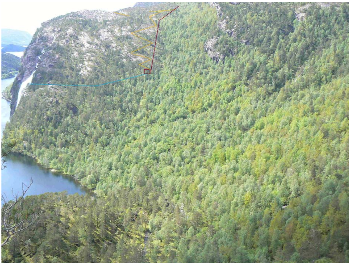
Figur 20. Dette bildet er teke frå aust mot utbyggingsområdet i nedre delen. Den raude lina som endar i den raude firkanten illustrerer røyrgata og kraftstasjonen. Utsleppsørøret er markert med blått, medan trase for tilkomstvegen er teikna med gult. Sentralt i bildet ligg den avgrensa edellauvskogen. (Foto; NN 2010 ©).
