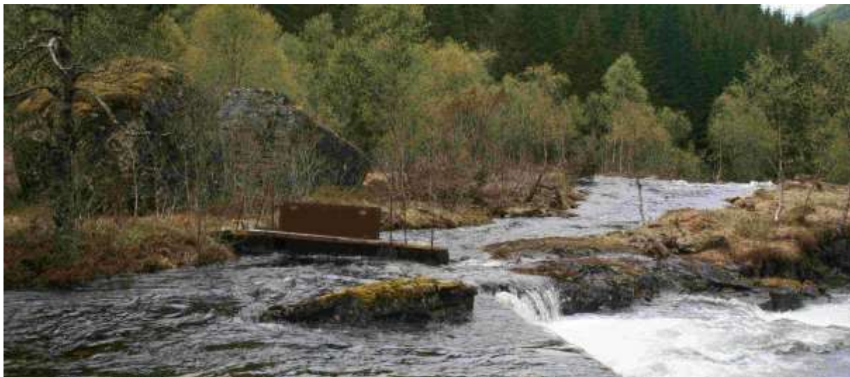
Figur 3. Her ser ein staden der noko av vatnet vert leia mot inntaksstaden til det gamle Osdalen Kraftverk. (Foto; Karl Johan Grimstad ©).
