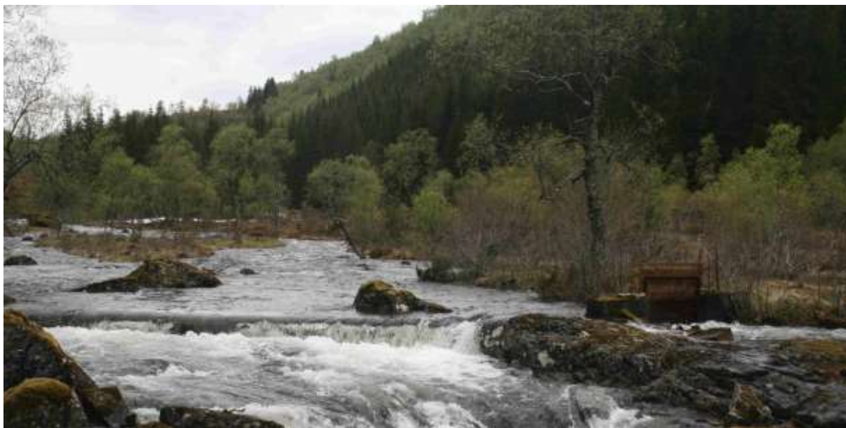
Figur 5. Dette biletet viser staden der deler av elva vert leia mot inntaket til det gamle Osdalen Kraftverk. Som ein ser er det ein leidemur til venstre på bilete, medan det er ein mur med ei jarnluke i framføre sjølje leidekanalen. (Foto; Karl Johan Grimstad ©).
