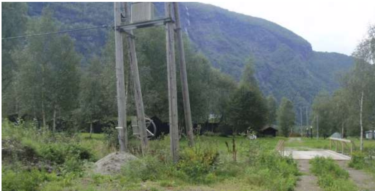
Figur 12. Biletet er teke like nedanfor rv. 55 ved Åselvi. Den produserte straumen vil verta overført til høgspantlina vi ser på biletet. Elles så ser ein at området langs elva er forstyrra, med campingplass på eine sida, og diverse vegar og anna anleggsarbeid på andre sida. (Foto: Bioreg AS ©).
