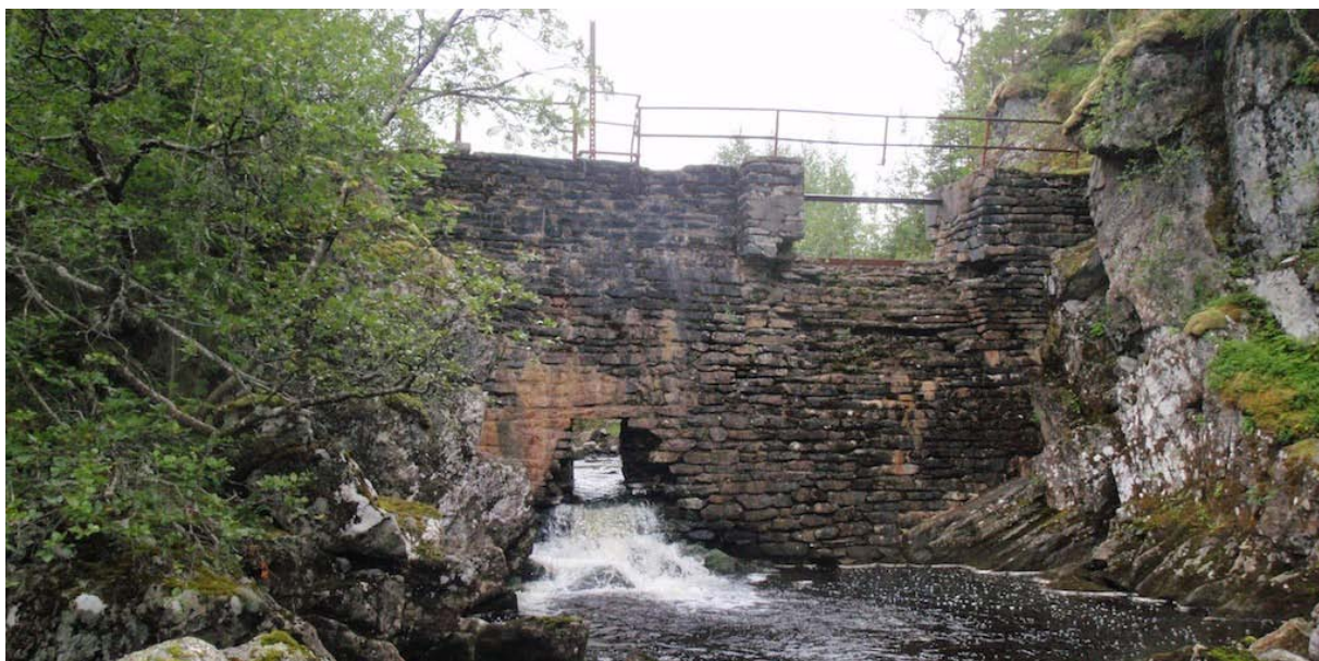
Figur 7. Her kan en se den ganske imponerende demningen nedenfor utløpet av Storårevatnet. Vi har fått opplyst at denne ble bygget for ca 100 år siden i forbindelse med etablering av et kraftverk nede ved sjøen. (Foto; Bioreg AS ©)
