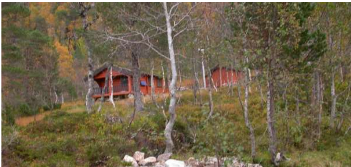
Figur 4. Litt nedom det planlagde inntaket ligg det ei ganske ny hytte. Her er det montert både ei lita vindmølle og eit lite 12-volts vassdrive straumaggregat. (Foto, Bioreg AS ©)
