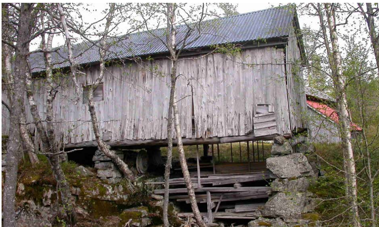
Figur 5. Biletet viser ei gamal vassdriva sag ved Daleelva rett nedom Svingesetvatnet. I bakgrunnen ser ein ei nyare sag som vart bygd då garden fekk tilgang på gratis straum ca 1920. Brukaren fekk også ein elektromotor til å dra saga som ein del av oppgjøret for fallrettane. (Pers meld. Ingebrigt Fænn). (Foto; Bioreg AS ©).
