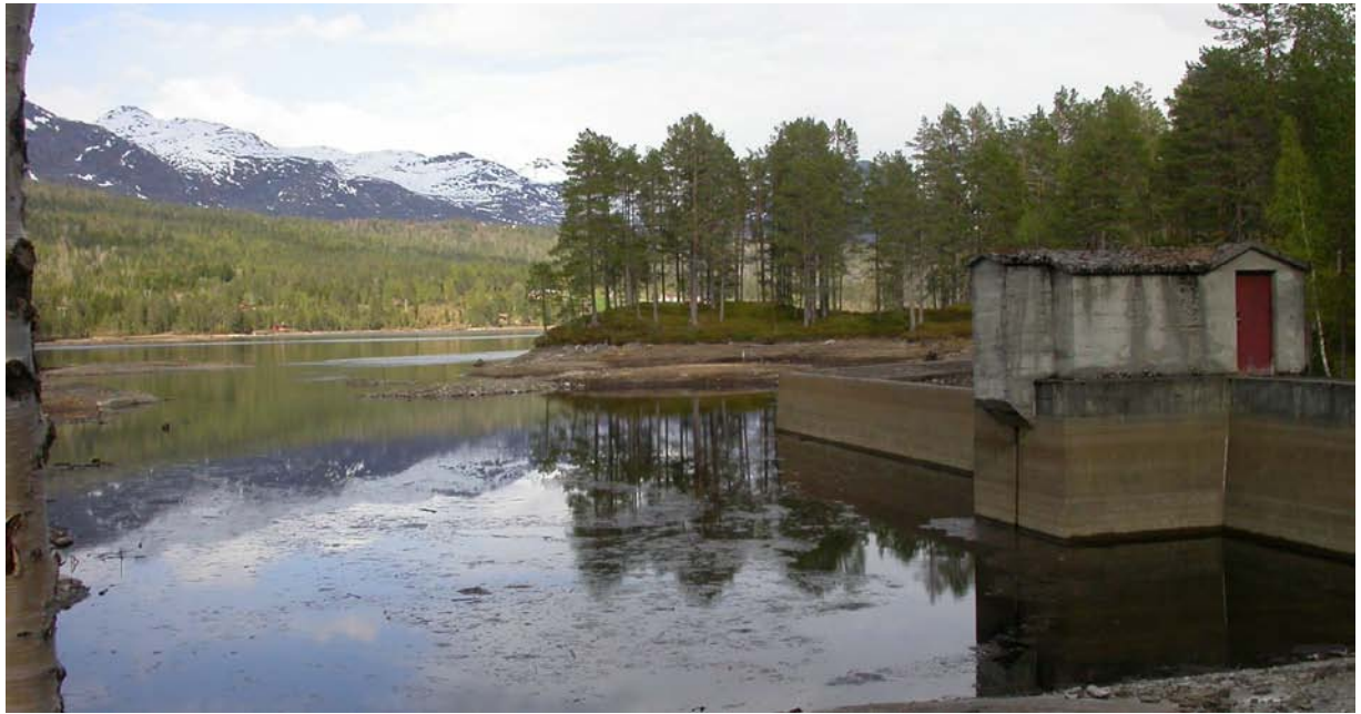
Figur 13. Dette bildet viser baksida av demninga ved utlaupet av Svingesetvatnet. (Foto; Bioreg AS ©).
