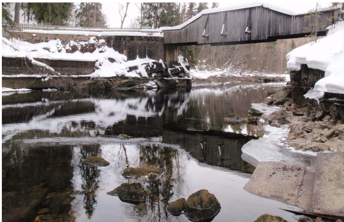
Figur 5. Bildet er tatt omlag fra der skulpturen skal utplasseres. Tilkomstveien for anleggsmaskiner er planlagt å gå ned til elven på venstre side nedenfor broa, for så å følge elveleiet under broa og opp til anleggsområdet. (Foto; Bioreg AS ©).
