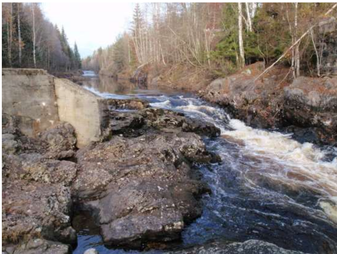
Figur 5. I området omlag midt på bildet må det bores, sprenges og graves for å få plass fundament for demning til inntaket. Det vil medføre utslipp av slam og partikler til elva, som potensielt kan skade bestanden av elvemusling nedenfor fossen. (Foto; Bioreg AS ©).
