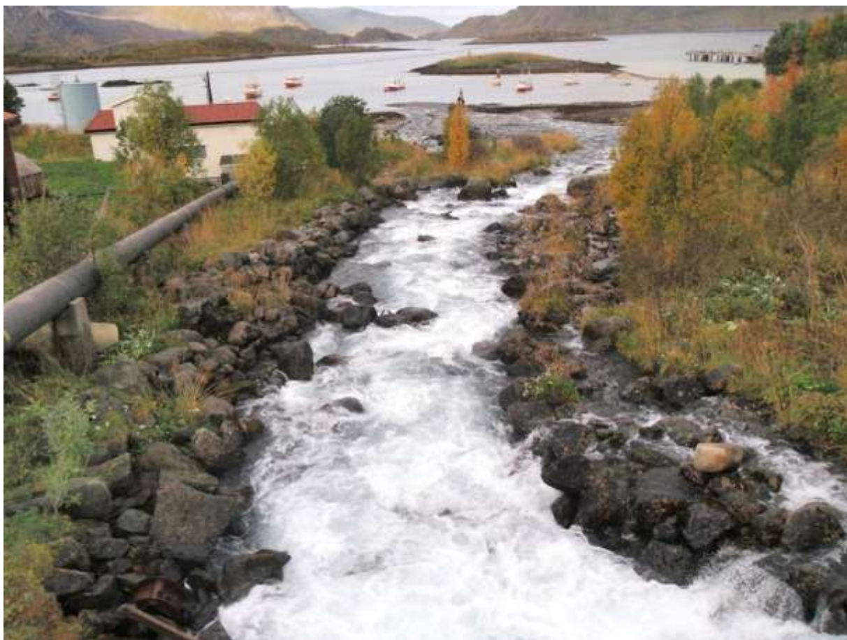
Figur 12. Bildet er tatt frå brua som går over Bergsfjordelva. Til venstre ser vi vassrøret som går ned til kraftstasjonen, den hvite bygninga på venstre side av elva. (Foto; Bioreg AS ©).
