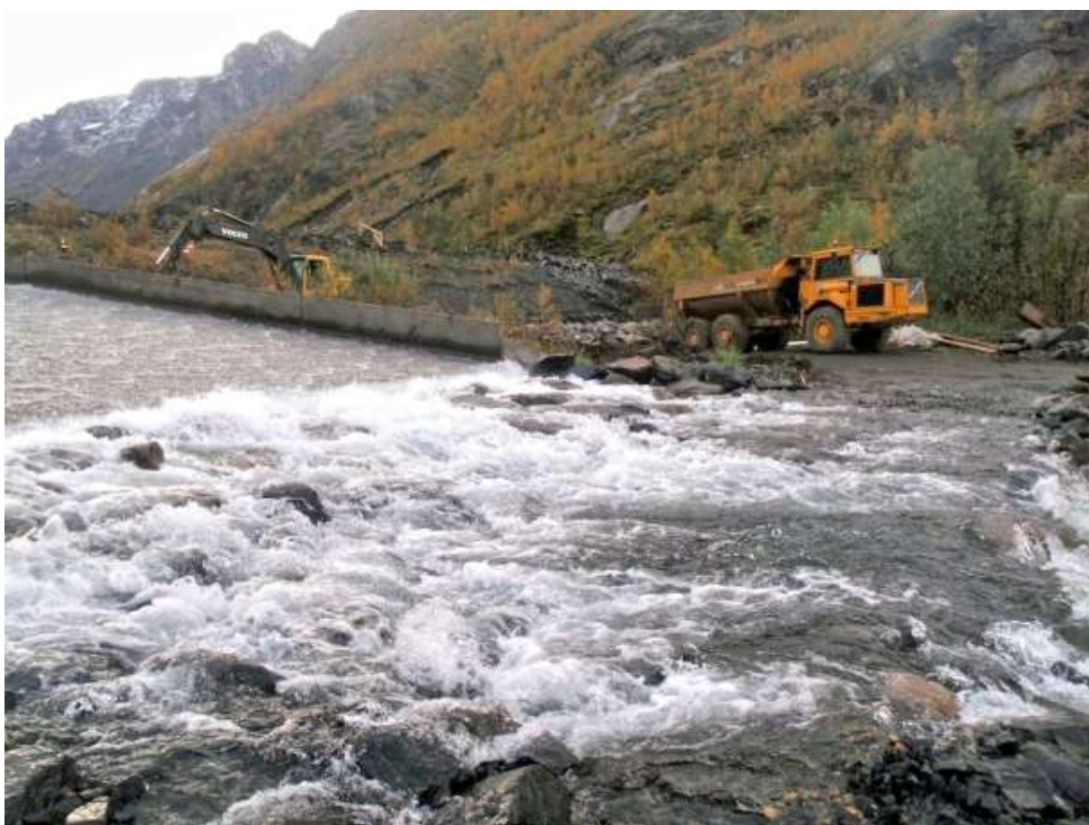
Figur 2. Bildet viser nederste del av overløpet (til venstre) samt nedsida av demninga. Da bildet ble tatt i september 2009 var det anleggsarbeid på stedet for utbedring av demningen. (Foto; Bioreg AS ©).
