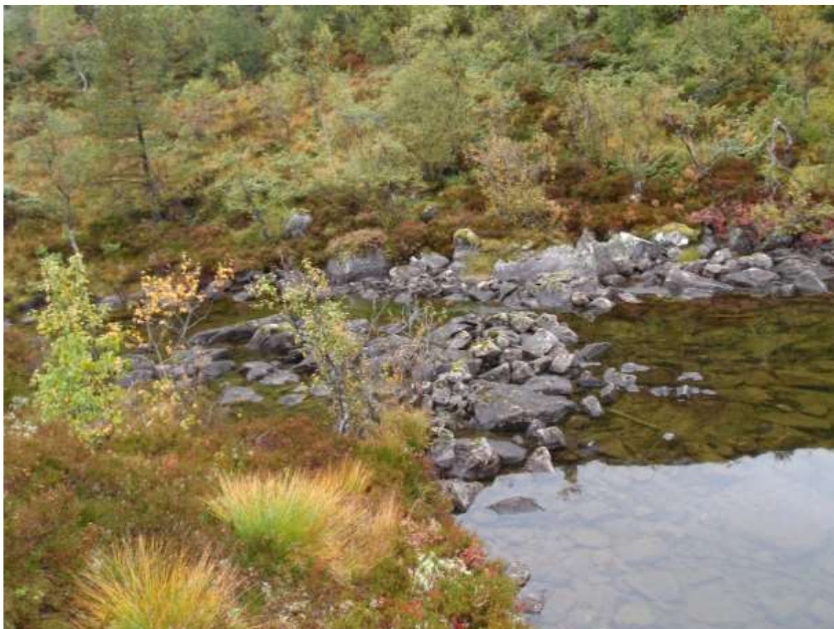
Figur 5. Biletet viser restane etter ei gammal demning i utløpet av Movatnet. Denne vart tidlegare brukt for å jamne ut flaumtoppane for ei kvern som stod på Maurstad sin grunn. (Foto: Geir Frode Langelo ©).
