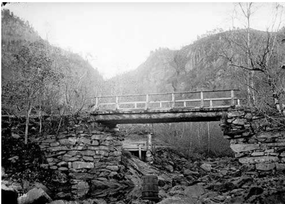
Figur 11. Biletet viser den gamle Kjerlandsbrua der den opphavlege bygdevegen passerte Hyrpo og Tveitelva etter samlaupet. Under brua til venstre for elva ser ein ei av dei gamle kvernene. (Biletet er utlånt av Ivar Kjerland).
