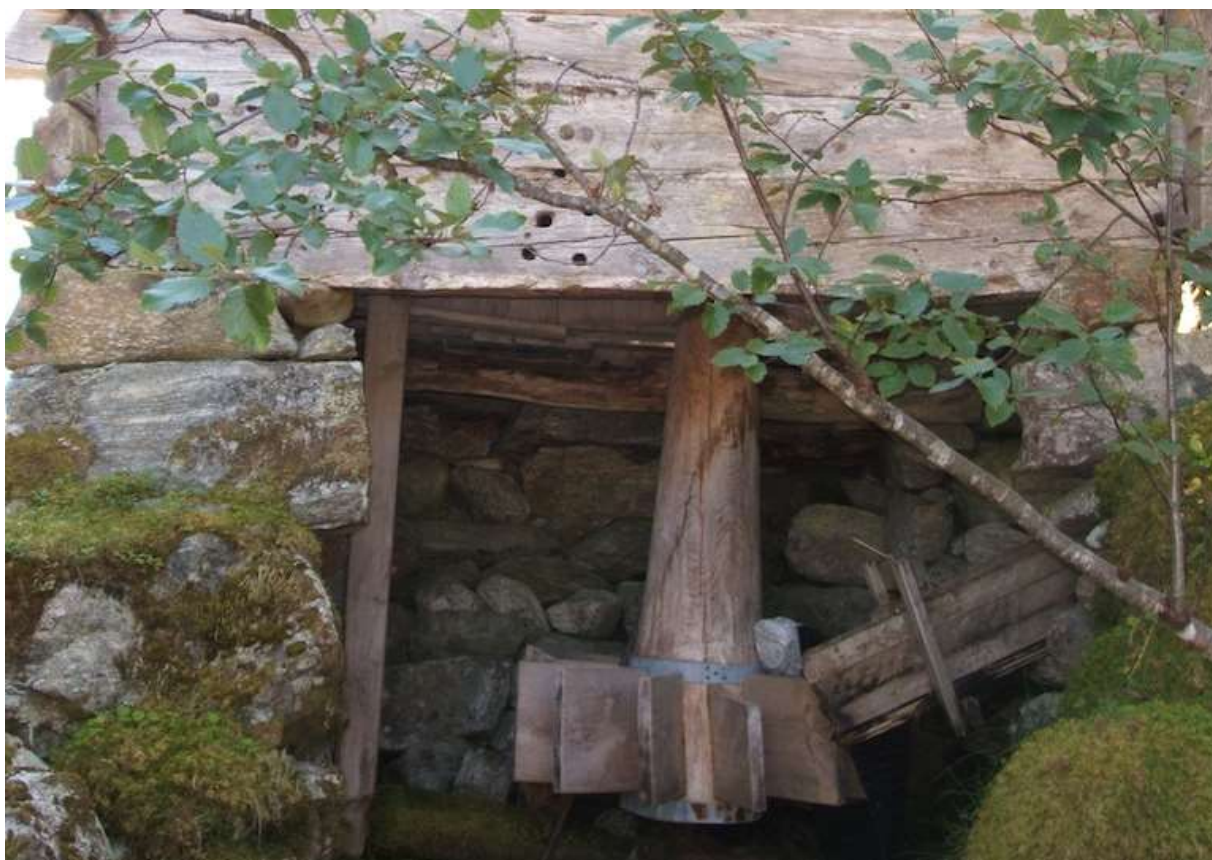
Figur 9. Biletet viser ei godt vedlikehalden kvern litt ovanfor garden Storstein. Som ein ser så er både vassrenna og kvernkallen på plass. (Foto; Geir Frode Langelo ©).
