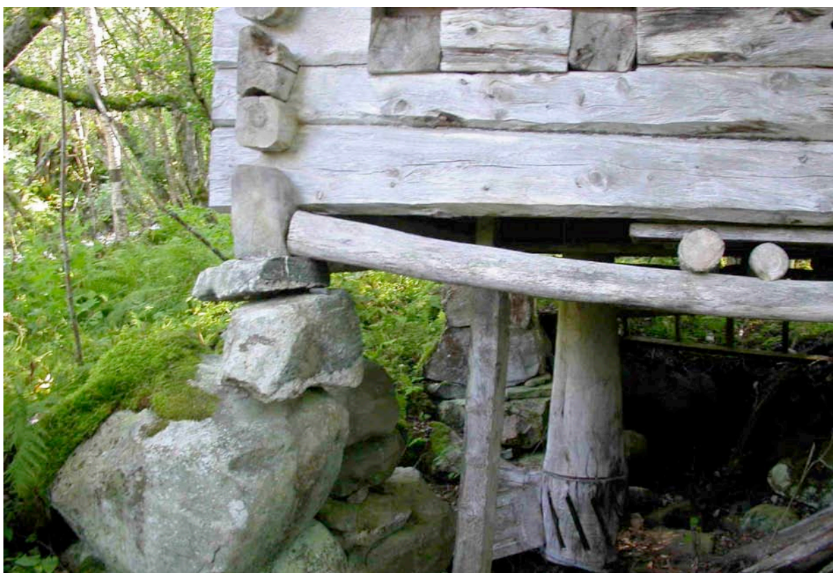
Figur 4. Biletet viser litt av eit gammalt kvernhus som står ved Skorga nedanfor riksvegen. Som ein ser er sjølve kvernkallen borte, men ein ser kvar skovlane på vasshjulet har vore festa på akselen. (Foto: Finn Gunnar Oldervik ©).
