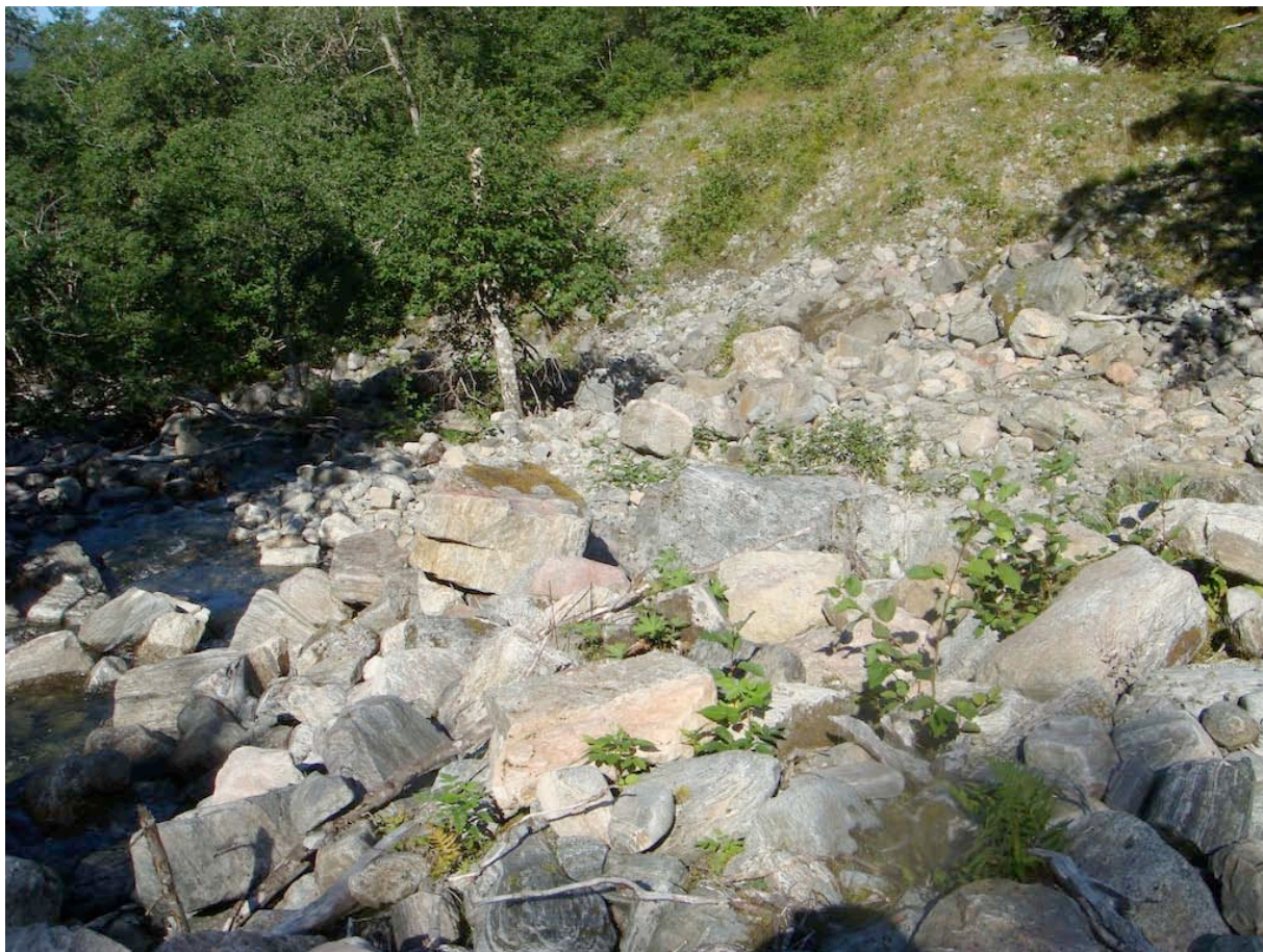
Figur 10. Biletet viser at fyllinga frå vegskjeringa somme stadar går ned i sjølve elva. (Foto: Geir Frode Langelo ©).
