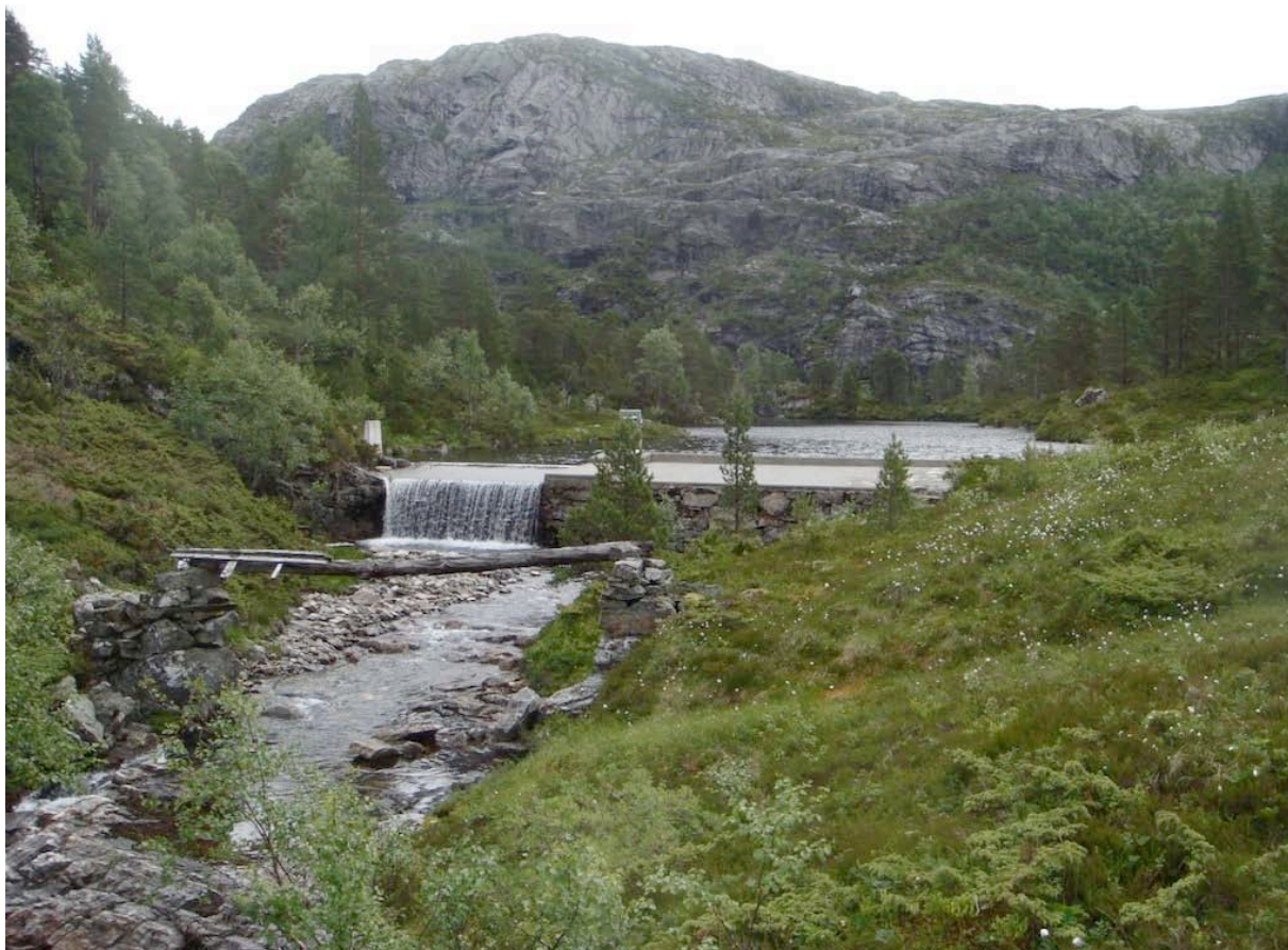
Figur 6. Her ser ein miljøet ved det planlagde inntaket ved utlaupet av Fjellbotnvatnet. På biletet ser ein også restane etter ei enkel bru over elva. Som ein ser er det litt triviell furuskog også såpass høgt over havet og med røsslyng og einer som dominerande i busksjiktet. Der det er myrlendt er det også noko røsslyng, gjerne saman med ymse myrullartar, bjørneskjegg, kvitlyng m.m. (Foto; Geir Frode Langelo ©)
