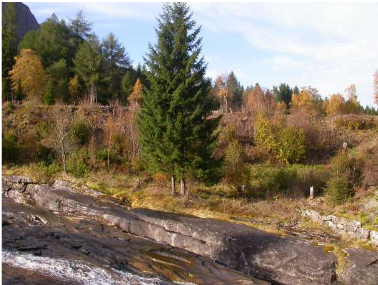
Figur 7. Biletet viser det planlagde stasjonsområdet ved ei eventuell utbygging av Tverrelva. Som ein ser så er det eit område som er forstyrta av ymse aktivitetar. Til høgre kan ein skimte ein mur, truleg ein rest av gamlebrua som før i ein flaum hausten 1924 (Kjelde; Selnes 2006). (Foto: Finn Gunnar Oldervik ©).
