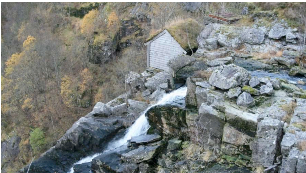
Figur 11. Dette biletet viser det gamle kraftverket frå 1950-talet. Som ein ser er det plassert akkurat ved starten av Brydalsfossen. (Foto; Karl Johan Grimstad ©).
